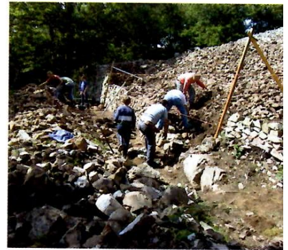
Chantier de restauration en cours (© G. Guillemot).
