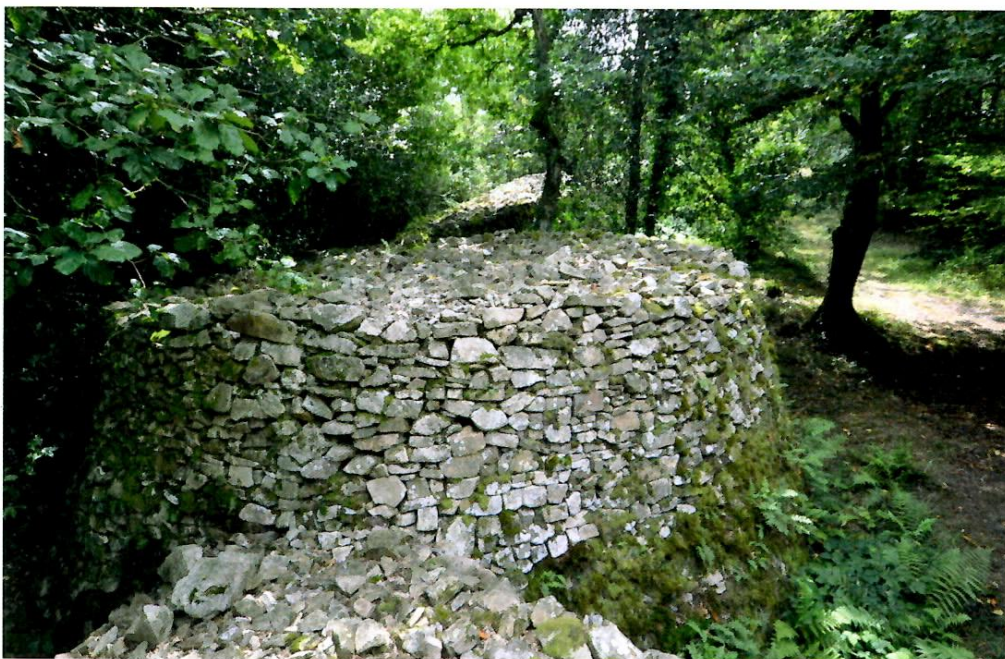
Tour pleine tronconique de l'angle nord-est (© Rodolphe Corbin).
